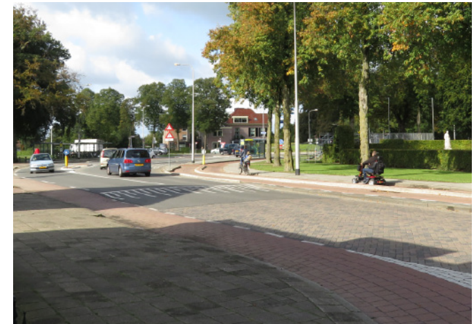
Dorpsstraat, overgang asphalt - klinkers
